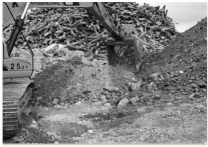
図 9.8.: バケットスクリーナーの積載
