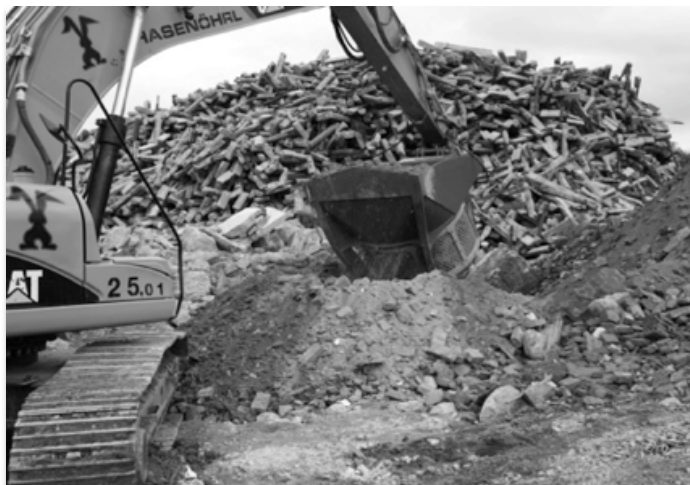
図 9.9: バケットスクリーナーの積載
